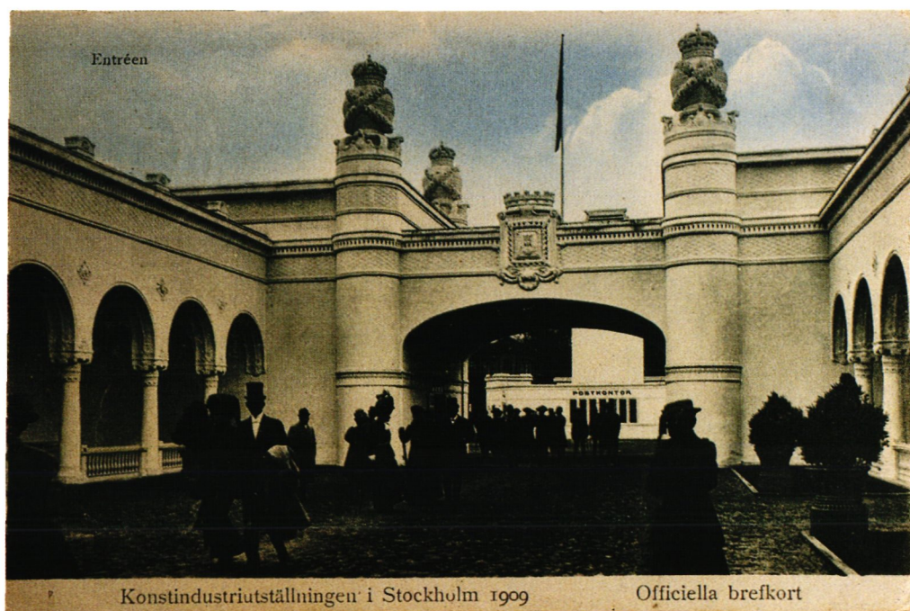
Baksidan av entrébyggnaden där utställningspostkontoret låg.
