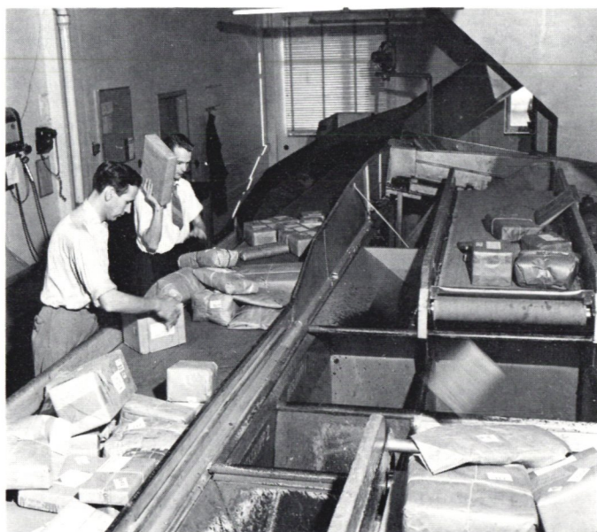
34. Grovsortering av vanliga paket. I fonden glidbana från paternosterverket, i vilket paketen förs upp från bottenvåningen. Foto 1956
