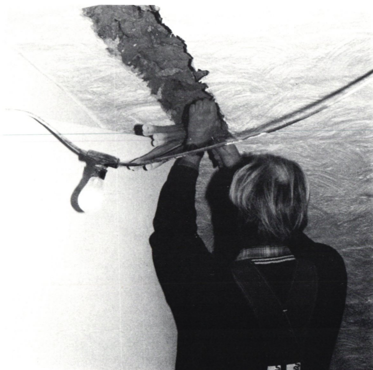
Från arbetet med förläggningen av elkablar i källarväggarna.
