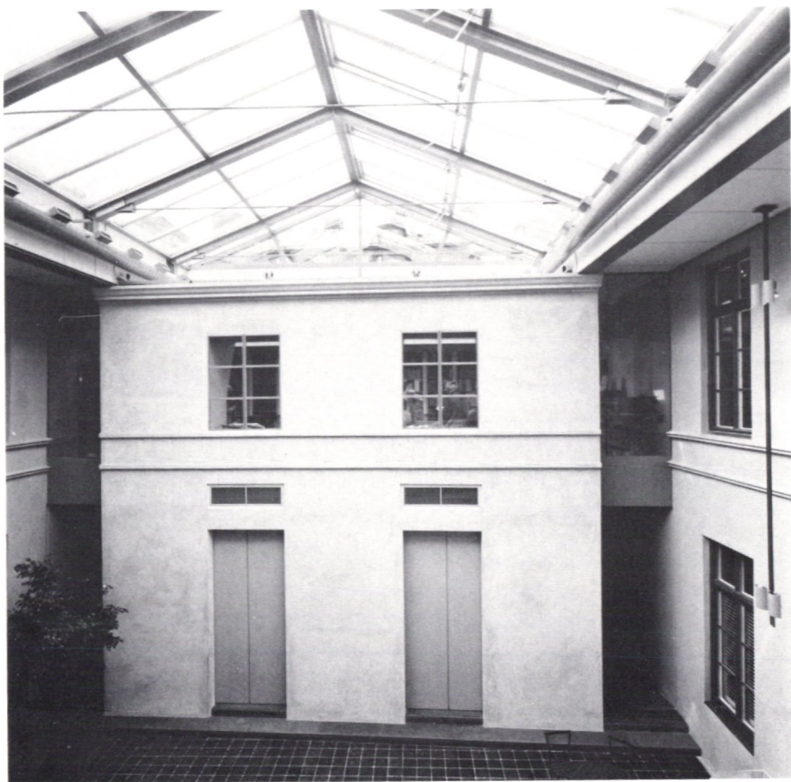
Utsikt över den nya putsade lättbetongfasaden mot Torget. Här syns hur flyglarna fortsätter in i filmsalen och biblioteket.
