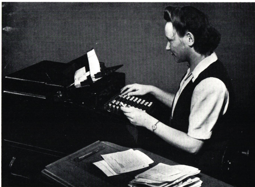
Denna för Postgirot specialbyggda bokföringsmaskin ansågs i begynnelsen som något av ett teknikens under.
