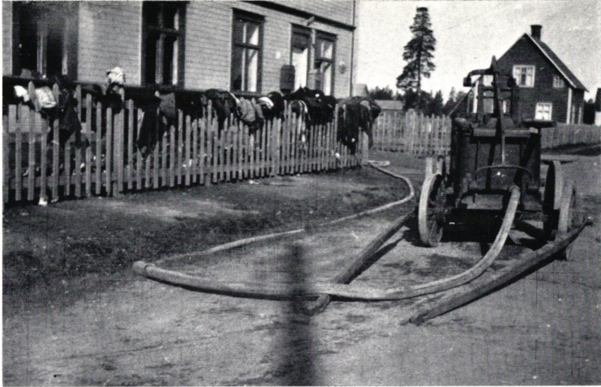
Efter branden i posthuset. »Den obrukbara brandsprutan».
