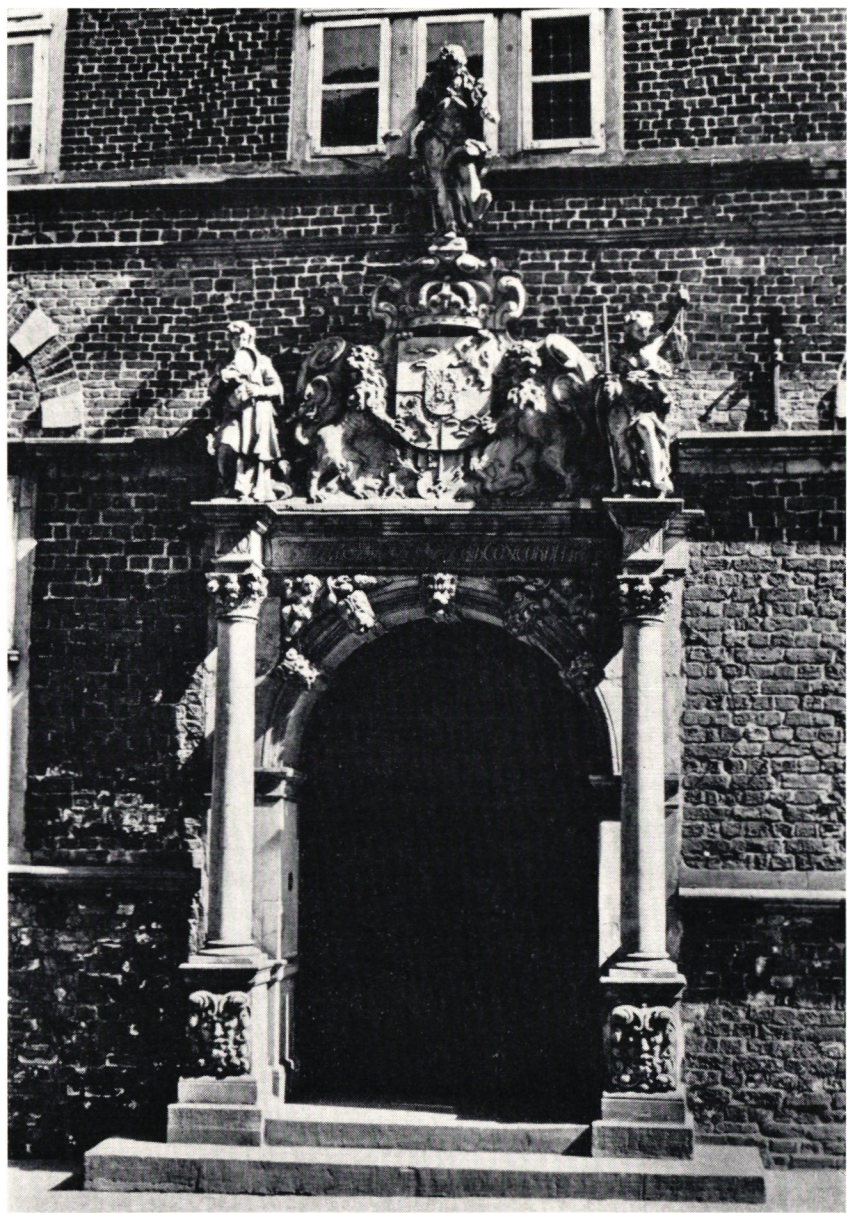
Barockportalen till rådhuset i Stade. Den kröns av det svenska riksvapnet och är över den högra kolonnen daterad 1667.
