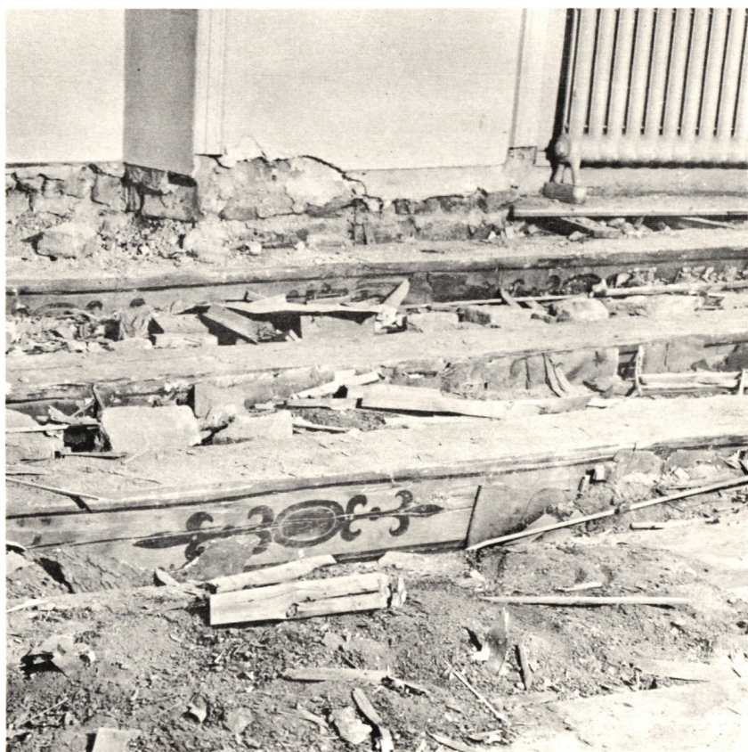
Golvet i nuv. amanuensens tjänsterum vid ombyggnaden 1955.
